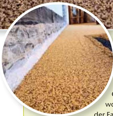
Daher ist das ganze Gebäude zuerst mit Metallplatten (auch die Spielgeräte wurden auf den Platten montiert) und dann mit Gummi-Rollbahnen ausgelegt worden und darauf wurde dann der Fallschutz auf einer Fläche von 220 m<sup>2</sup> gebaut.
