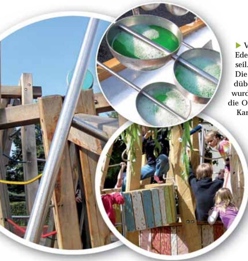
► Verbaut wurden 40 m<sup>3</sup> Eichenkernholz, 240 lfd. Meter Edelstahlrohr, 180 lfd. Meter polyamid-ummanteltes Stahlseil. Sämtliche Verbindungselemente bestehen aus Edelstahl. Die tragenden Konstruktionselemente sind mit Schwerlastdübeln auf der Grundplatte befestigt worden. Die Hölzer wurden im Vorfeld mit Eisenoxyd und Kalk künstlich gealtert, die Oberfläche mit dem Hochdruckreiniger strukturiert, die Kanten grosszügig geschliffen.
